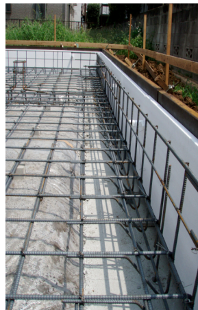
ベタ基礎の配筋
