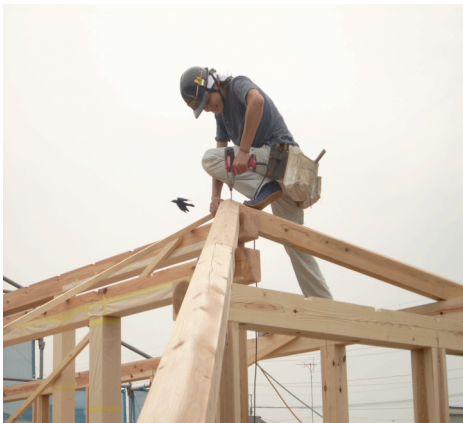
上棟時：棟梁の向うに飛ぶ鳥は？
