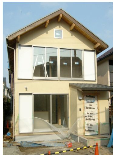
バルコニー取付前の外観です
