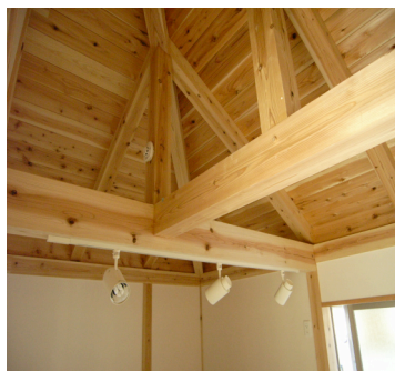
杉板現しの天井
